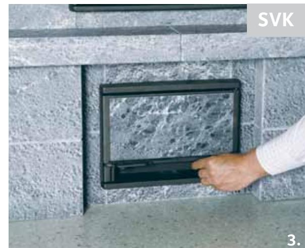
vypnite digestor, alebo strojné vetranie. Pokiaľ nie je k peći privedený externý prívod vzduchu, prívodné vzduchové kanály sa nachádzajú pod klapkou popolníka. Polohy regulátora pre prívod vzduchu sú znázornené na obrázkoch 2 a 3.
