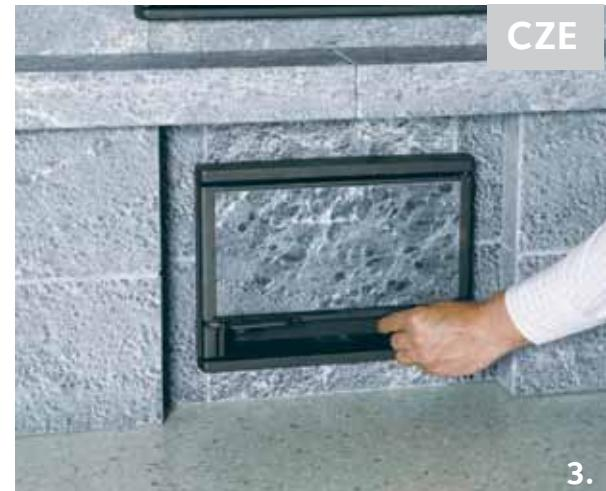
ku). V případě potřeby vypněte odtah a strojní větrání. Ne-ní-li spalovací vzduch přiváděn přímo zvenku, jsou přívodní vzduchové otvory topeniště umístěny pod klapkou po-pelníku.
